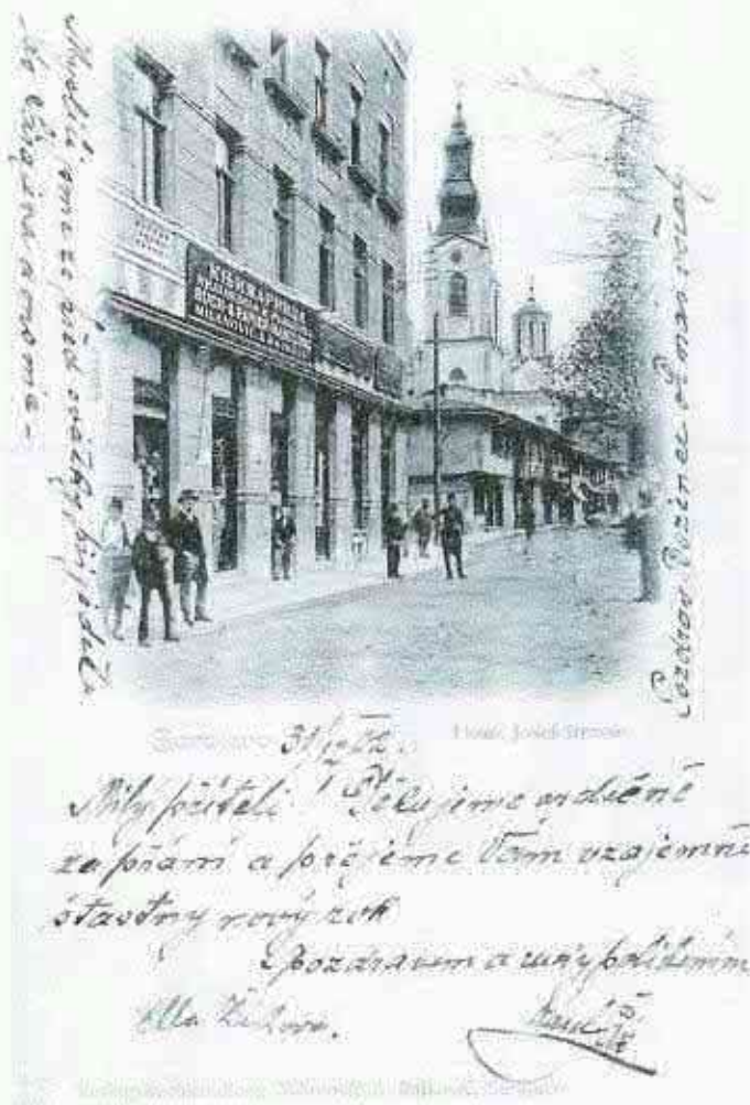
Pogled na Sabornu crkvu iz Ulice Franje Josipa (danas Zelenih beretki). Jasno se vidi niz stambenih objekata lociranih uz ulicu na mjestu današnjeg parka. Tipične visine, sa prizemljem i doksatno izbačenim spratom, viševodnim, čeramidom pokrivenim krovovima.
