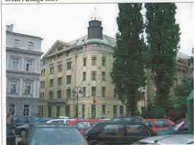
Stambeno-poslovna zgrada na uglu Zelenih beretki i Muhameda Kantardžića, nekad Hrvatska banka
