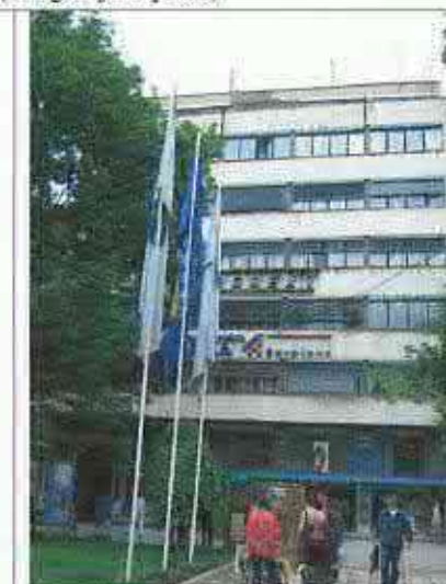
Ferhadija, Zgrada „Projekta“
