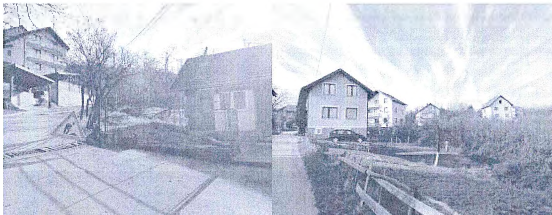
I transverzala (postojeći objekti na izlazu iz tunela – lijevo, ulazu u tunel – desno)
