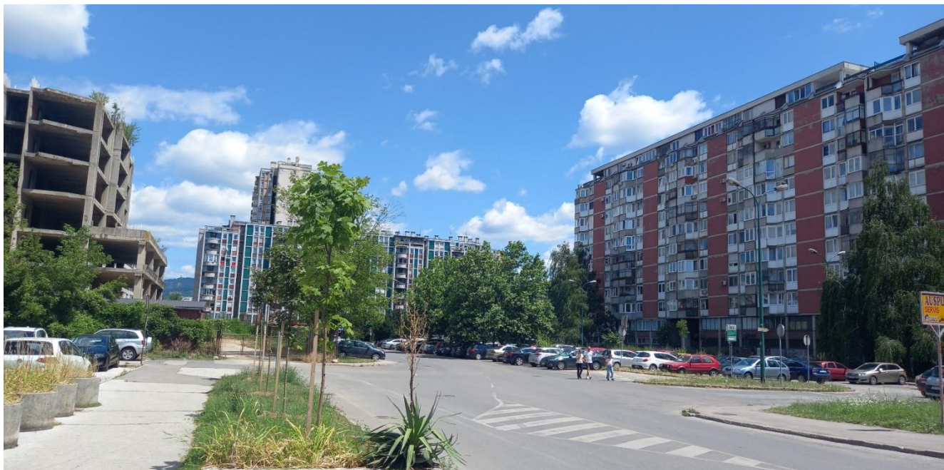
Pogled na lokaciju iz Kolodvorske ulice
