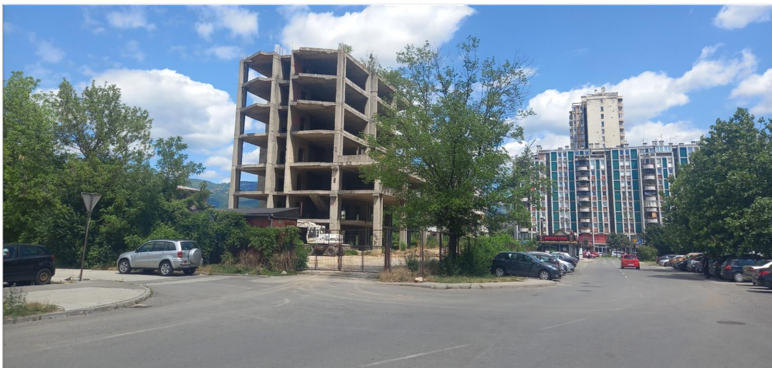
Na lokacija planiranog objekta MUP-a KS nalazi se nedovršeni objekat poslovno dispečerskog centra „Vodovoda i Kanalizacije“, koji će biti uklonjen prije gradnje centralnog objekta MUP-a KS.
